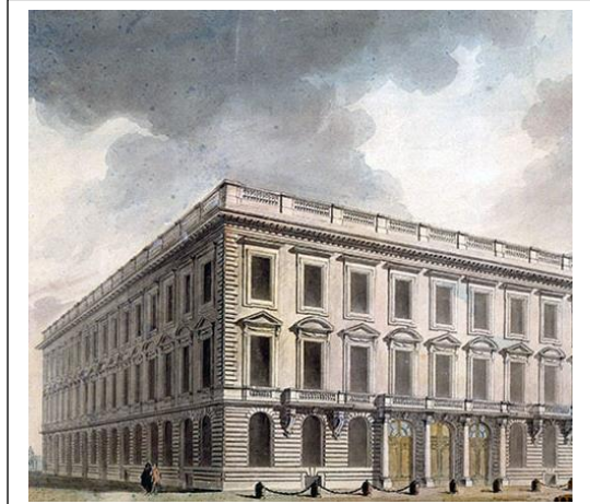
Hôtel particulier dit de « Monsieur Saige », construit à Bordeaux au XVIIIème siècle
